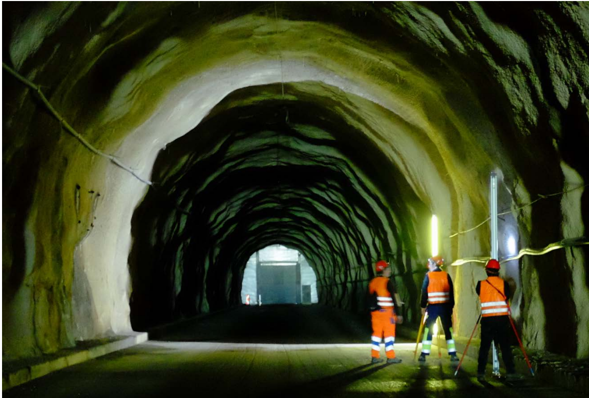
Präzisions-Nivellement im Zugangsstollen zum Felslabor Mont Terri, 2017
