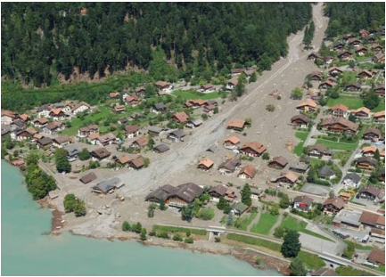
Murgänge laves torrentielles
