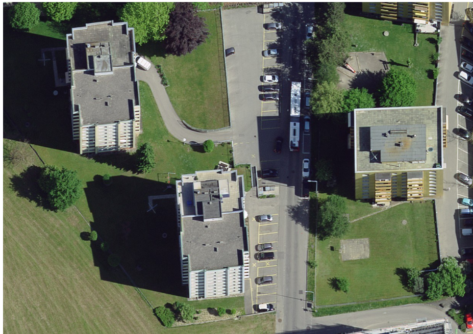
Beispiel von Gebäuden, welche gegen Norden verkippt sind
