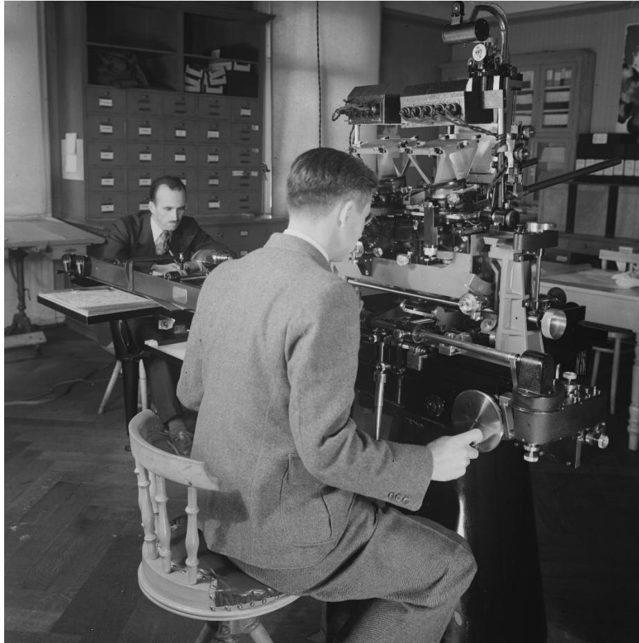
Bei der anschließenden Auswertung wurden die Koordinaten und die Höhe der Aufnahmepunkte berechnet und in das photogrammetrische Auswertegerät eingegeben.
