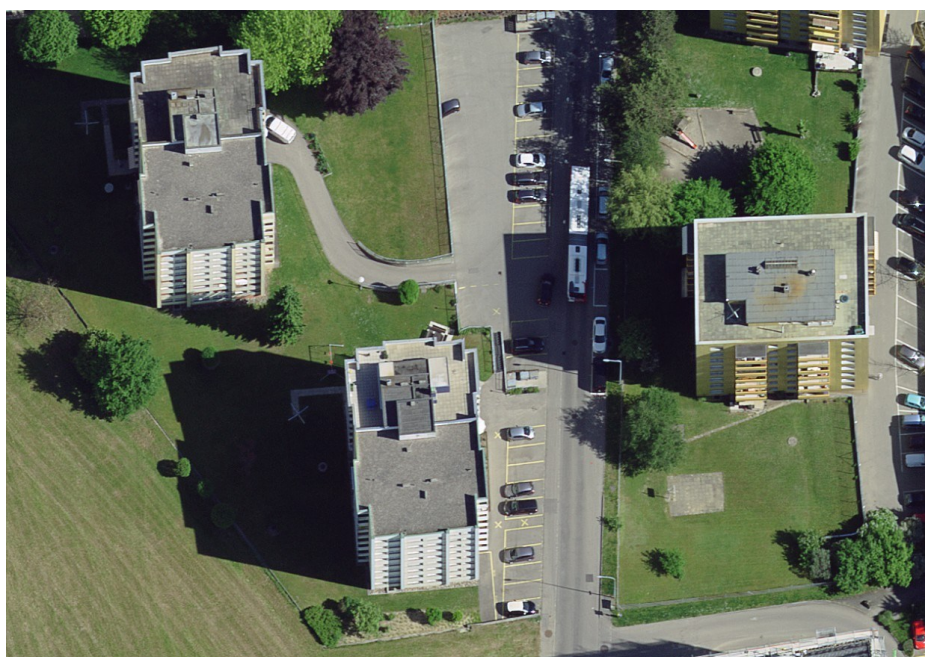
Exemple de bâtiments qui subissent un déversement en direction du nord
