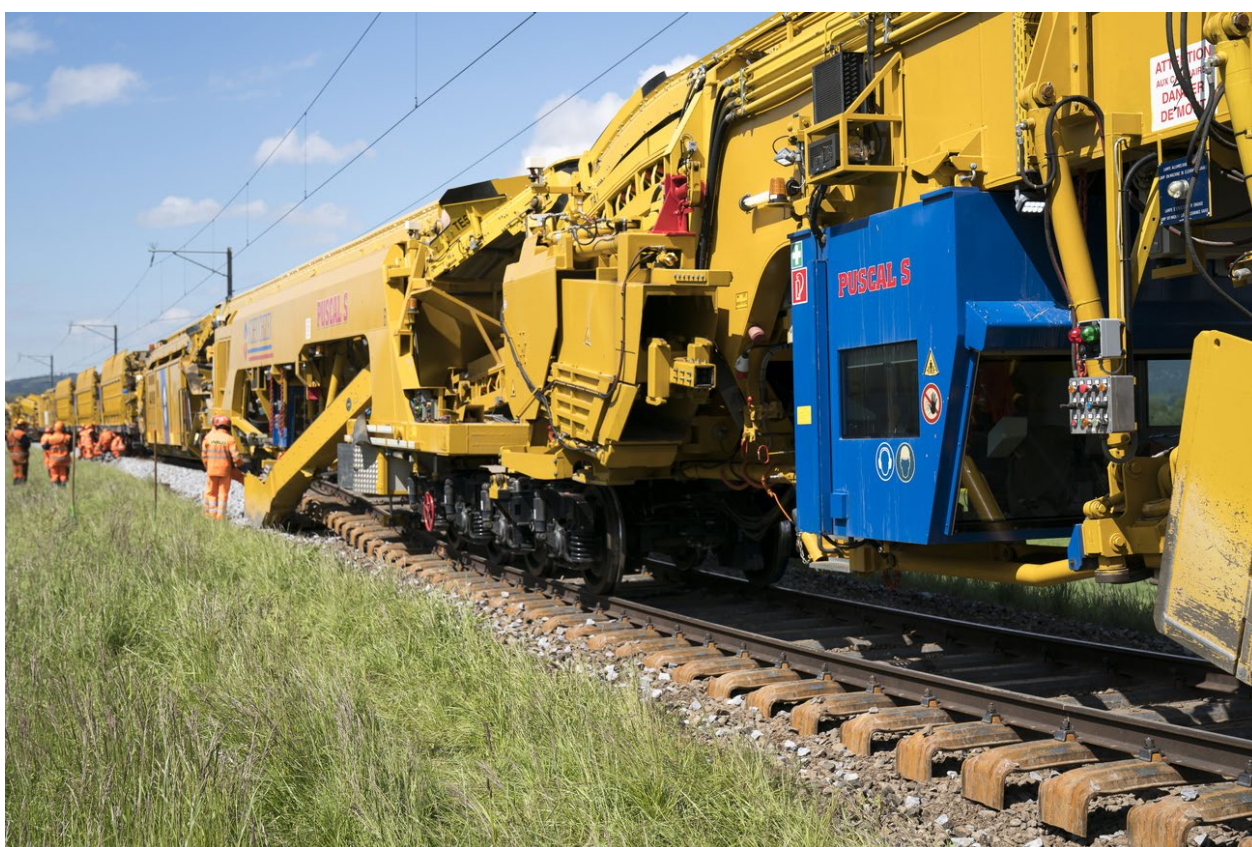
Fig. 10: Réfection de voie avec un train d'assainissement: Les rails et les traverses sont soulevés, le ballast ferroviaire ancien (brun, à l'avant-plan) est retiré et criblé, puis il peut être reposé comme ballast RC en combinaison avec du ballast ferroviaire primaire (gris clair, à l'arrière-plan). Photo: Keystone SDA.
