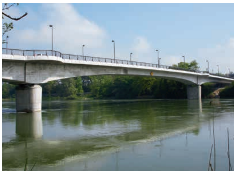
Ponte di confine sul Reno a Laufenburg (AG). Coordinate unitarie a livello internazionale nella misurazione nazionale contribuiscono a collegare i ponti anche al di là dei confini.
